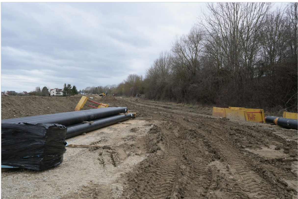
Abb. 6: Baumaßnahmen zur Fernwärmeanbindung (Foto: Jungwirth, 2024).
